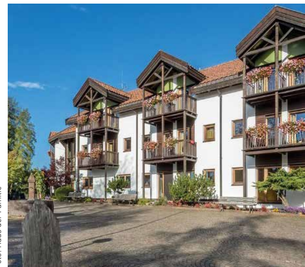
Blick auf das Wohngebäude
